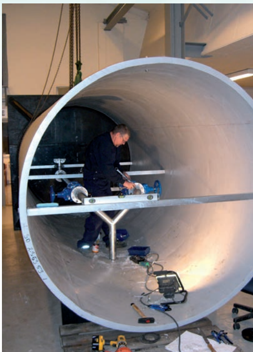
Montage af trykrør
