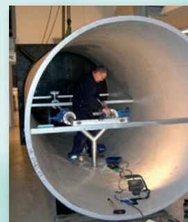
Koblingsfødder, rustfri rør, ventiler, travers og banket monteres
