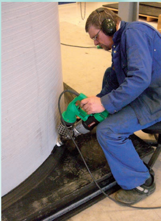
Svejsning af brøndrør på bundplade
