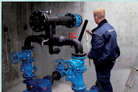
Opbygning af en tørtopstillet selvansugende pumpestation i beton
