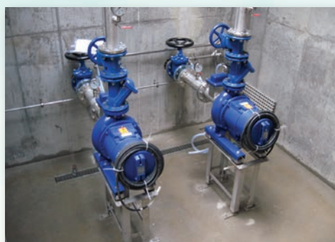
Tørtopstillet pumpestation klar til brug
